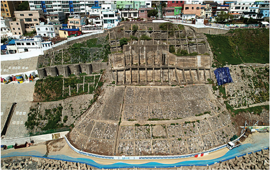
급경사지 붕괴위험지역인 영선지구 사진
