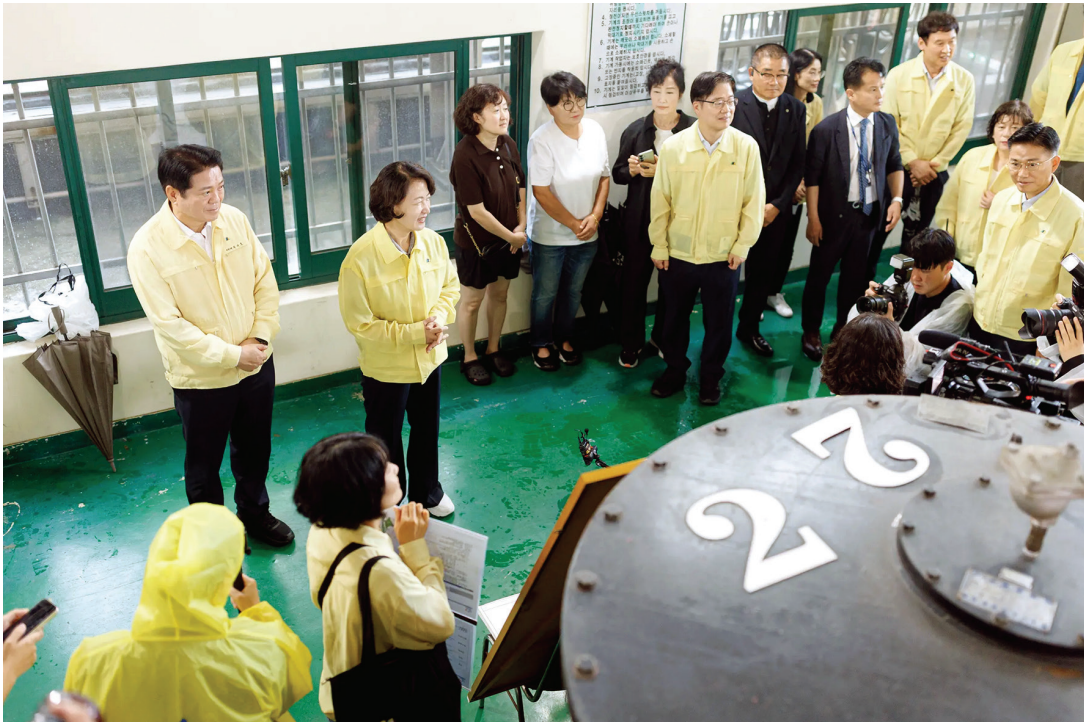
안양시 만안구 석수동 반지하주택 밀집지역과 연현배수펌프장 여름철 호우 대비상황 점검 모습
