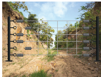
02 인장형 와이어로프 설치
