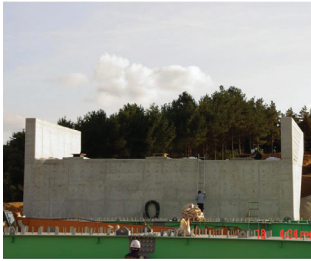
기초, 벽체, 날개벽 시공
