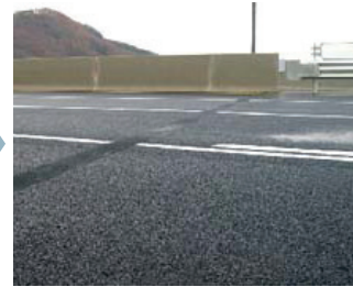
신축조절장치 및 충전재 시공
