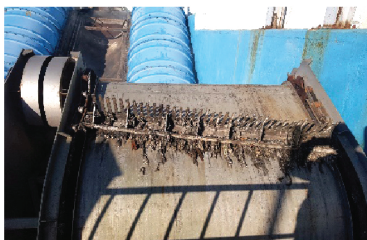
중량물에 의한 레이크 및 구동체인의 파손방지.(시설운영 안정성 증대)
