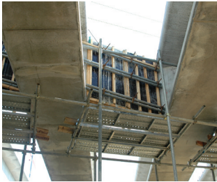
블록 사이 무수축콘크리트 타설
