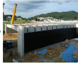
거더 크레인 가설
