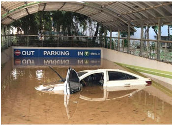
포항 지하주차장 침수('22)
