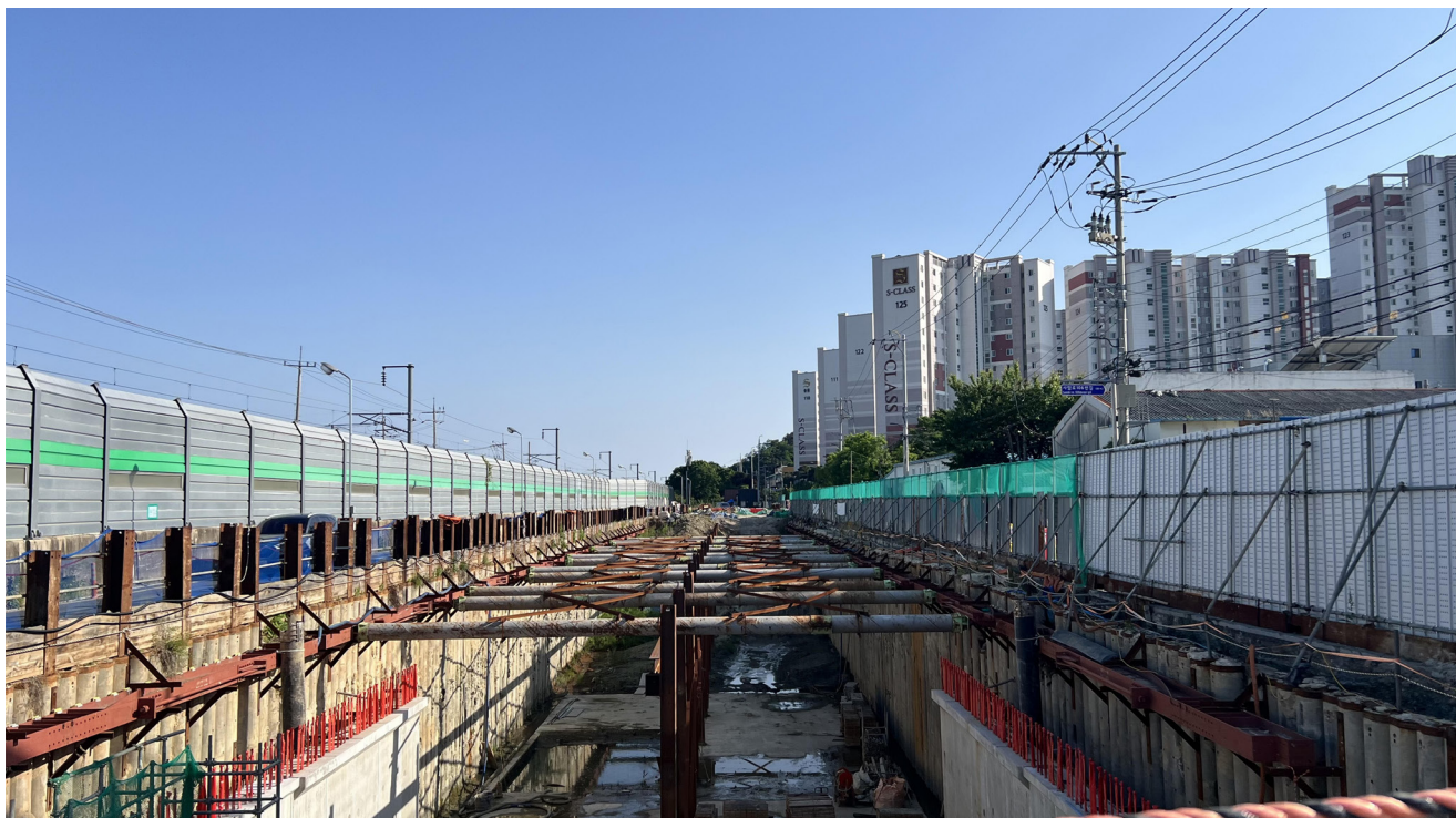
우산지구 우수저류시설 공사현장
