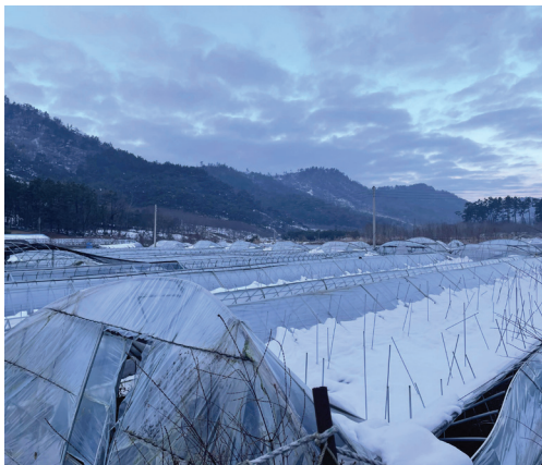
대설로 인한 사설하우스 파손
