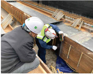
강형 용접 및 비파괴검사
