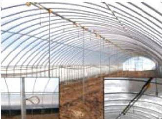
보강지주 설치 전경
