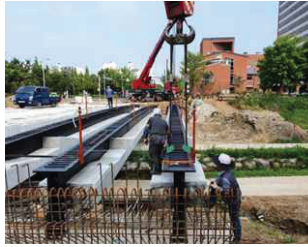
크레인을 이용한 거더 가설
