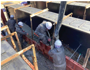
콘크리트 타설 및 다짐
