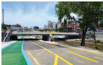
도림천 단면확장(교량 재가설)
