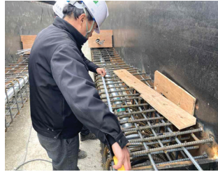
철근 및 내부정착구 설치
