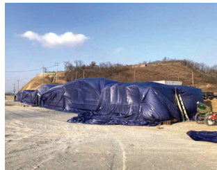
케이싱 콘크리트 증기양생
