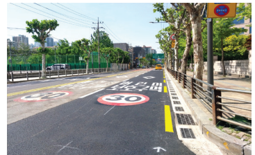
서운로 연속형 빗물받이 설치
