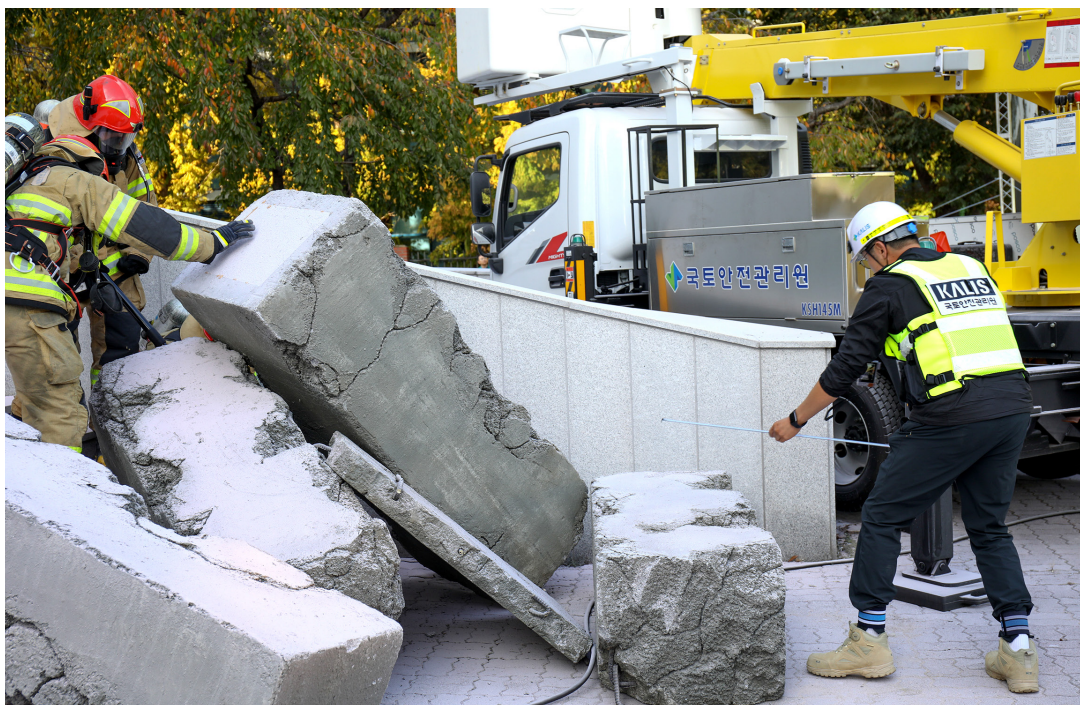
2024년 재난대응 안전한국훈련 (건물 붕괴 가상훈련)
