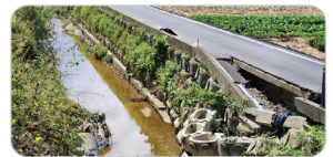
하천 제방 유실
