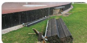
축제장 시설 파손
