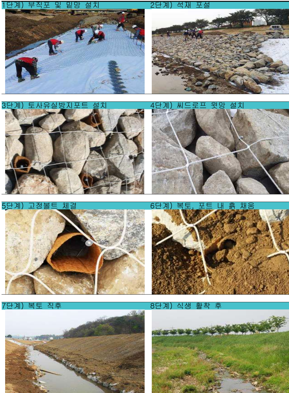
[표 3] 시공 공정 사진
