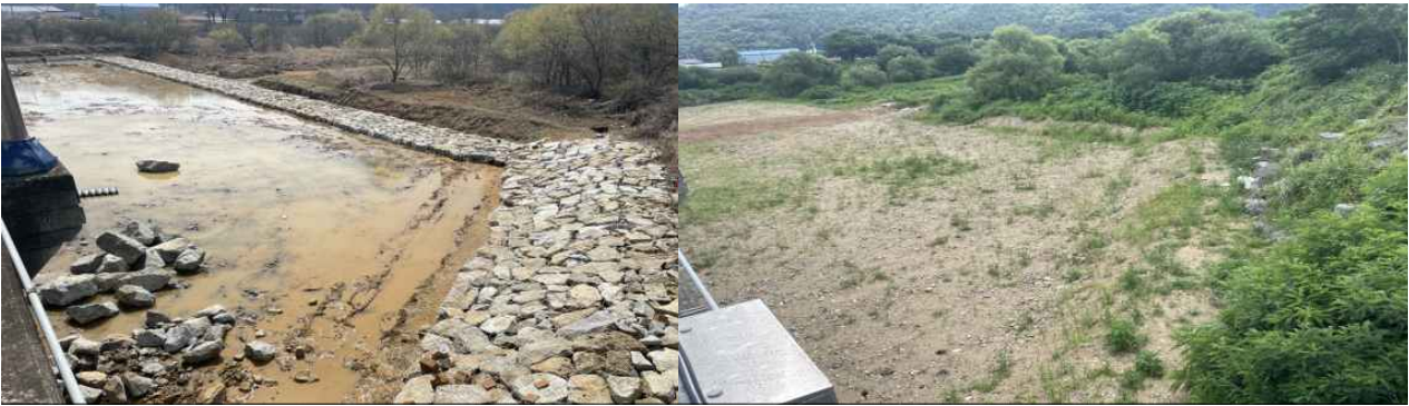
석문천 지방하천 정비사업(강원 횡성군)_사면 보호공
