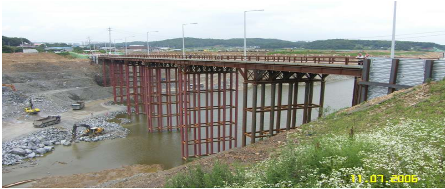
< 굴포천2단계 공사중 가설교량(목상교) >
