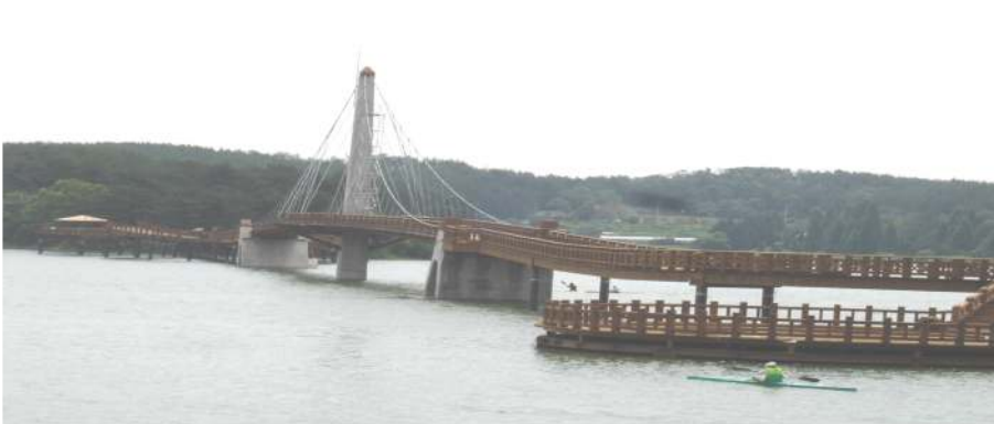
< 은파 보도현수교 가설공사 중 주경간교 및 접속교 설치공사 >
