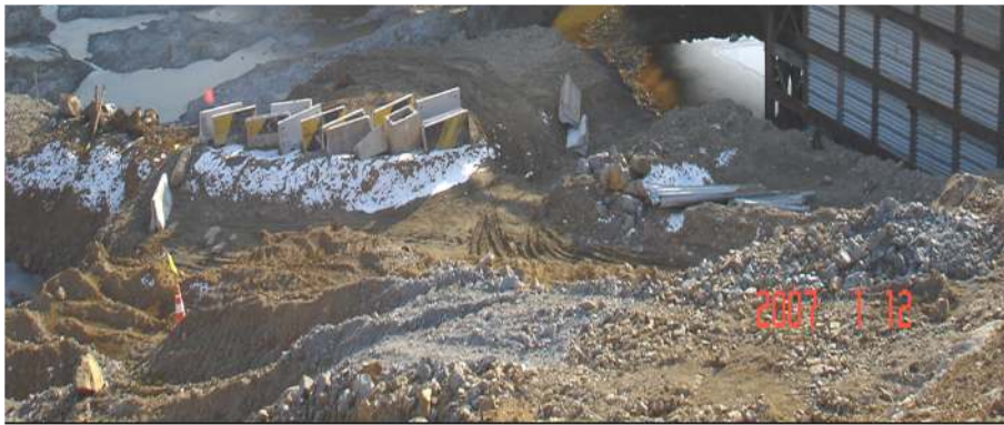
< 성남판교지구 국지도 23호선 지하차도 건설공사 >
